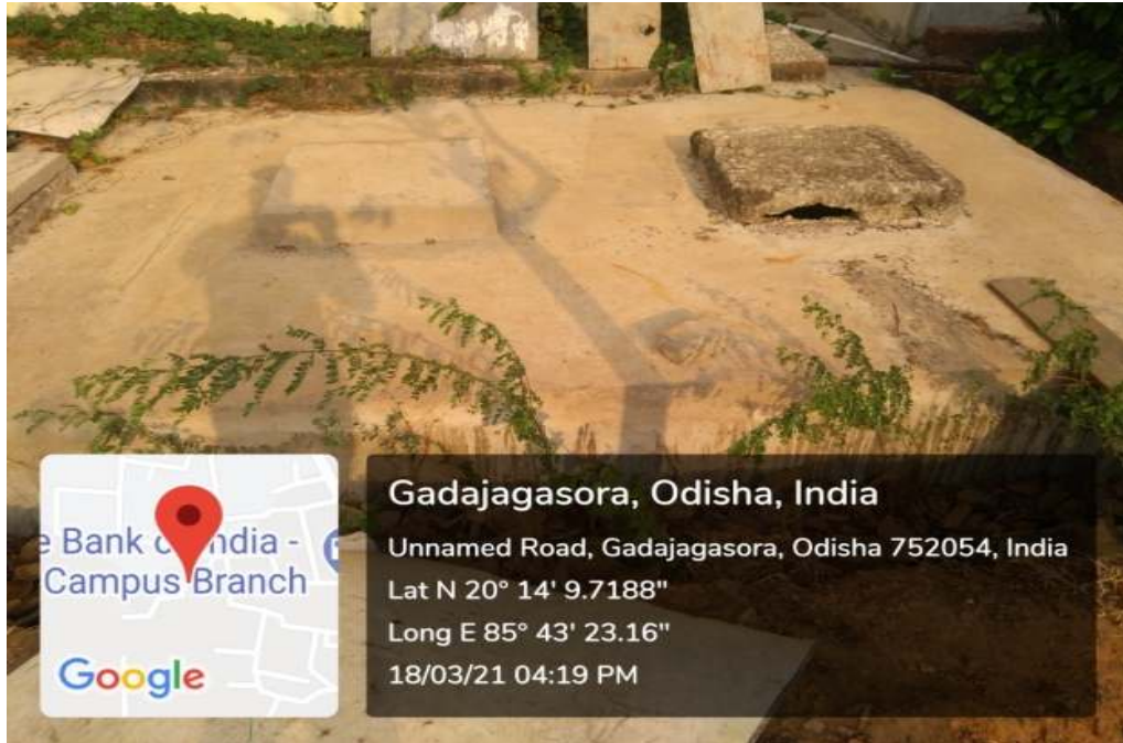
(Waste Water pit 2)
