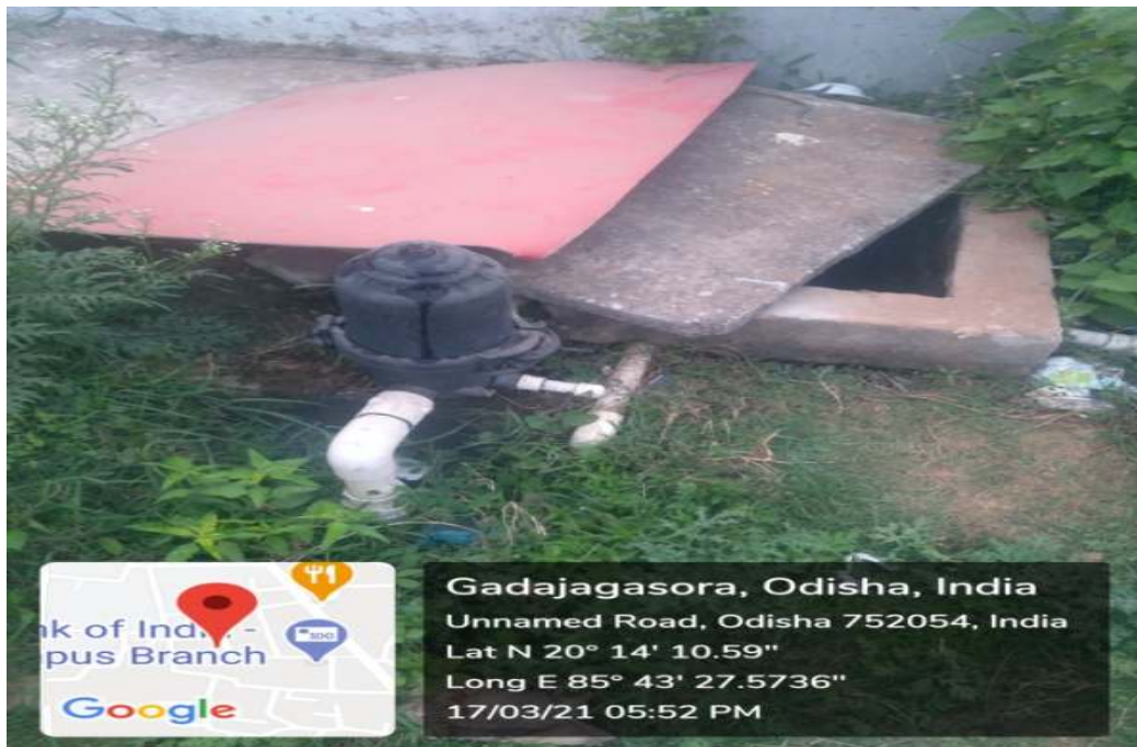
(Waste Water pit 3)
