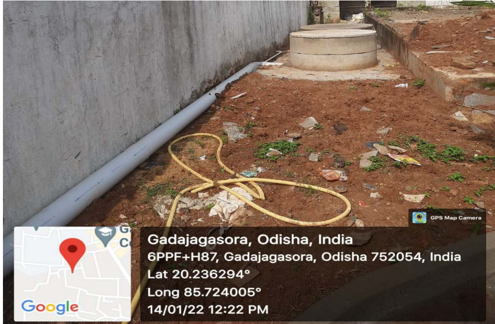
(Waste Water pit 4)
