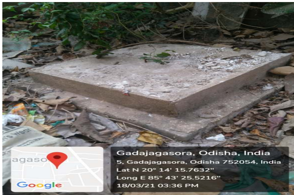
(Waste Water pit 1)
